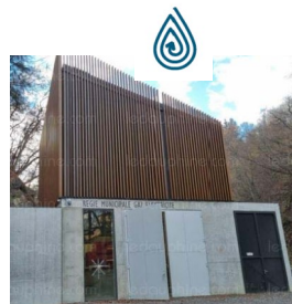
Hydroélectricité Sallanches « Centrale sur la Sallanche » 2,9 MW soit 7,3 GWh/an
