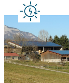
Solaire PV agricole Éloise Toiture 1 350 m 2 0,3 GWh/an
